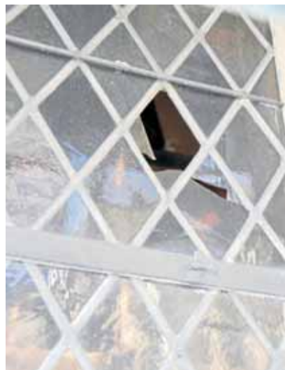
Die Fenster werden im Januar repariert.
